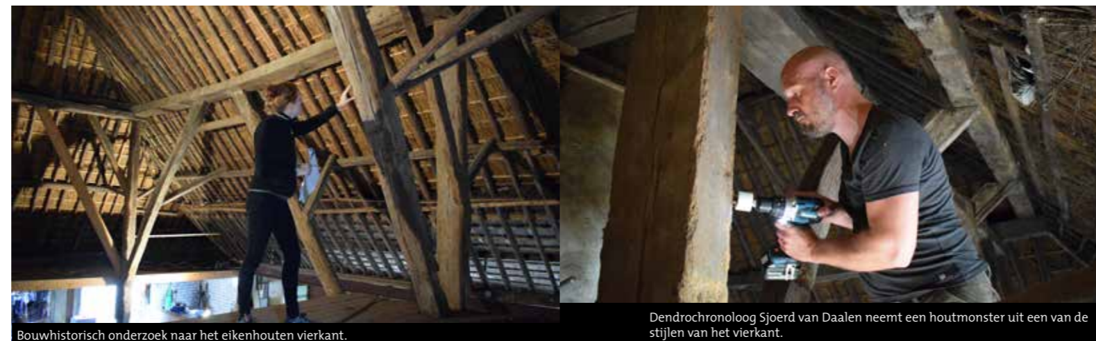
Bouwhistorisch onderzoek naar het eikenhouten vierkant.
