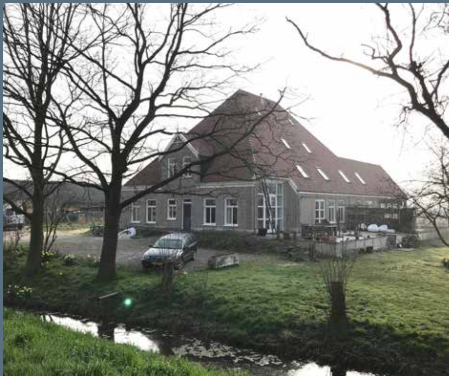
Situatie na renovatie
