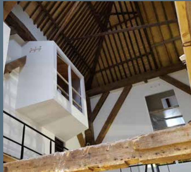
Interieur in aanbouw
